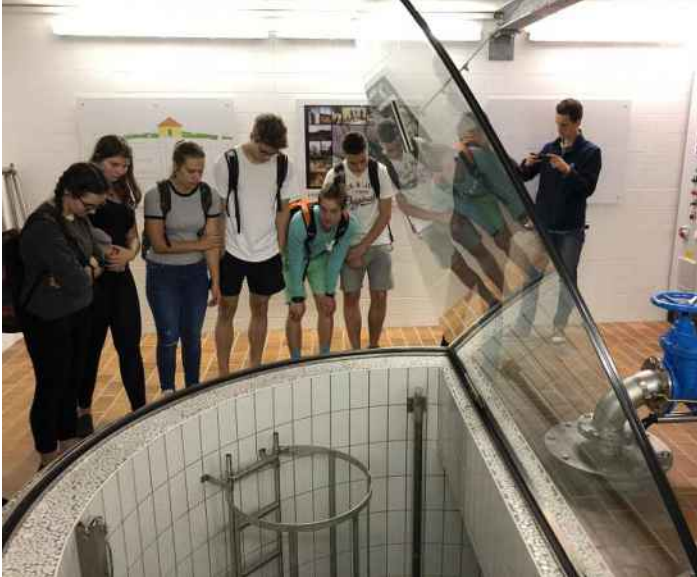
Modernste Anlagen versorgen die Bevölkerung mit Wasser
